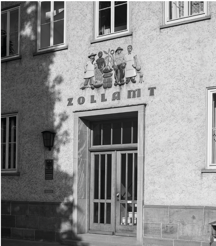
Abb. 2: Portal des Zollamts mit Supraporte, zwischen 1950 und 1956
