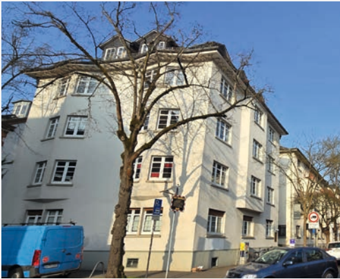
Heutiger Blick auf das ehemalige Wohnhaus der Familie Reis in der Friedrichstraße 2 in Marburg
